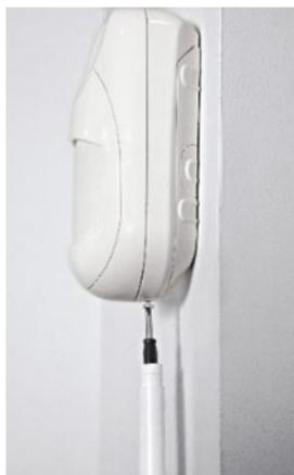
5. Insérez et serrez la vis dans le trou situé en bas du détecteur, pour sécuriser le détecteur à son support de fixation..
